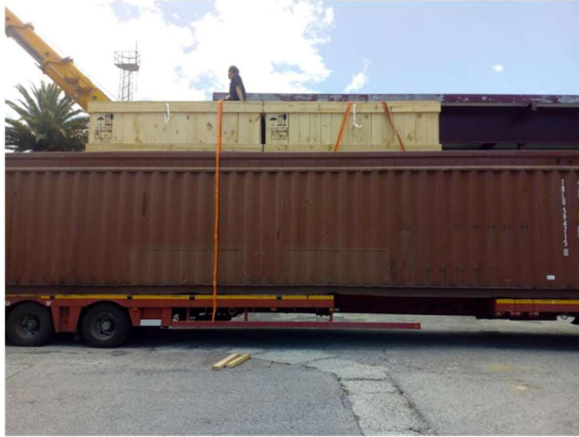
オープントップコンテナ内のトランス
