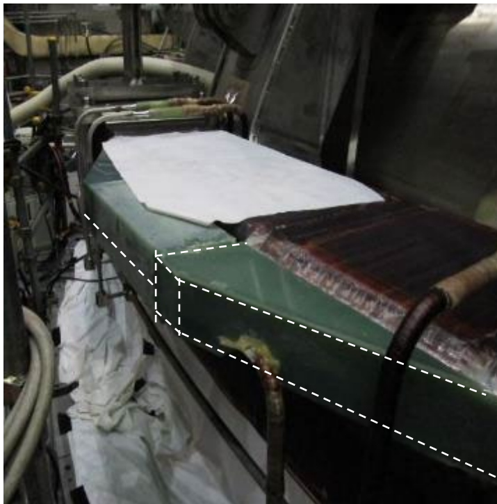
図 2.2-2 パンケーキジョイント（箱型）の例
