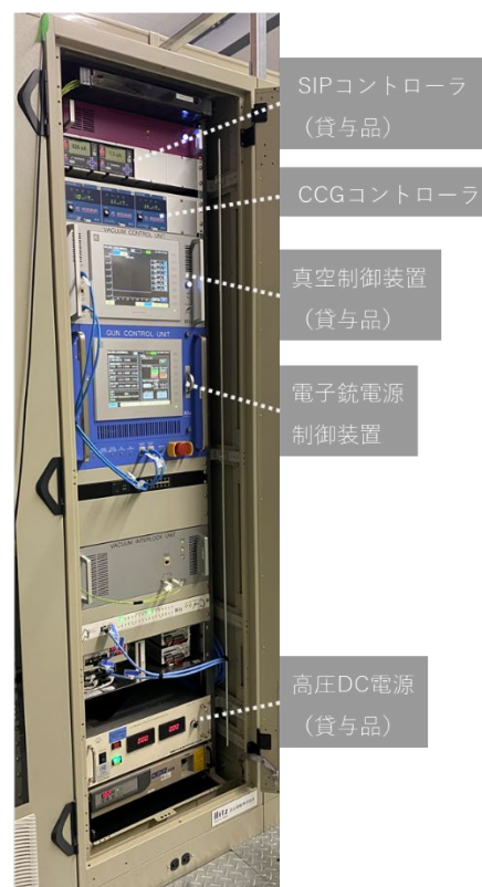
図 4. 高電圧ステーションおよび 19 インチラックの実装例の参考図 (写真)
