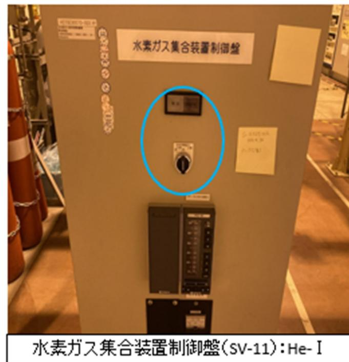
図 20 水素ガス導入系ガス供給機器電磁バルブ操作盤（現場盤） 外観図
