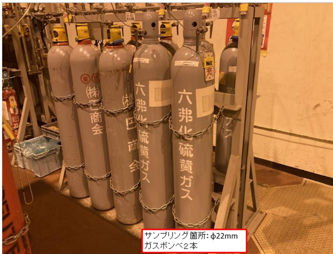
図 16 SF6 ガスボンベ 外観図
