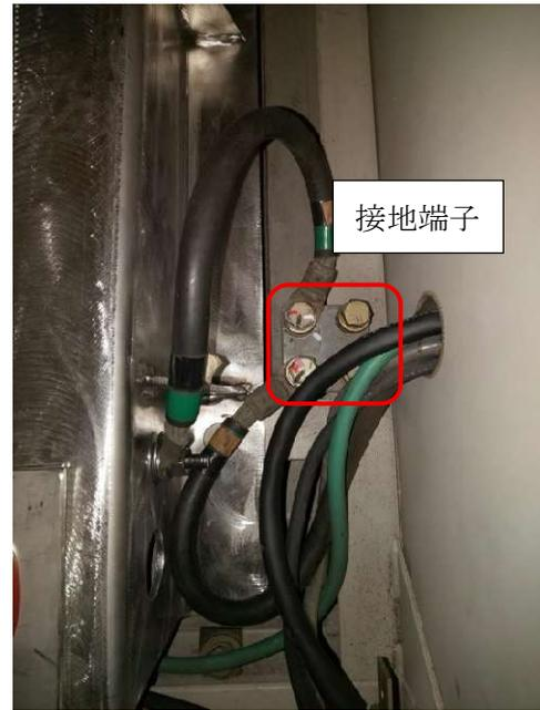
図6 リアクトルの温度センサ用ケーブル端子台 図7 盤内接地線接続端子(既設盤下部)
