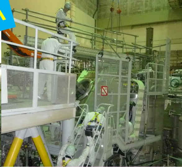
安全柵・冷却水配管の取付
