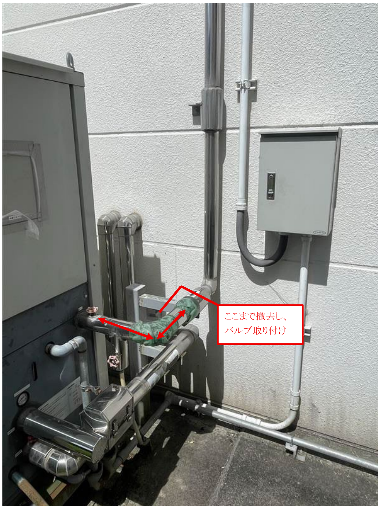
図 4 敷設配管分解範囲(2/3)
