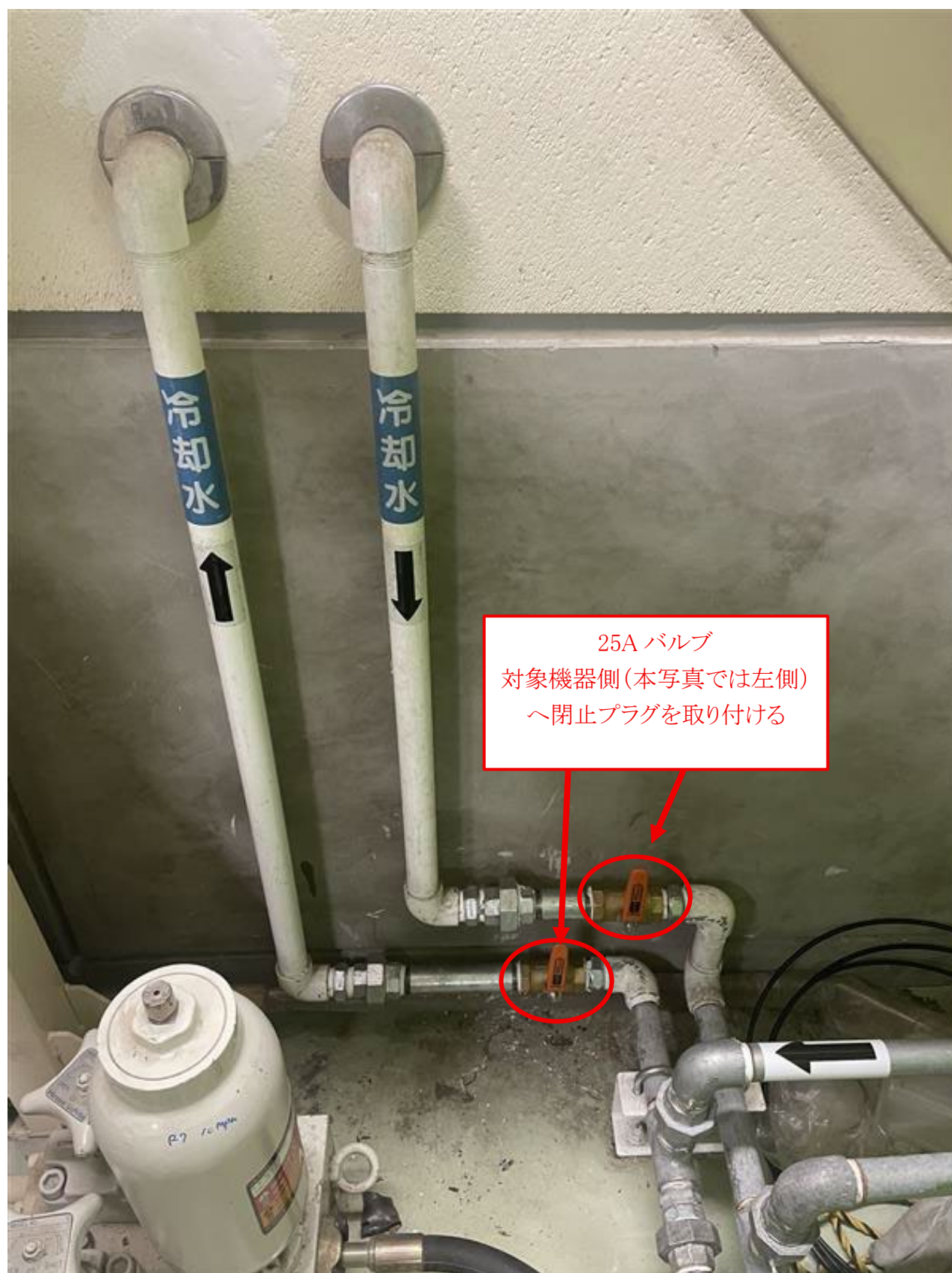
図 5 敷設配管分解範囲(3/3)
