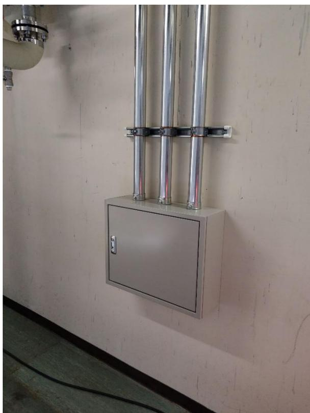
写真 5 : RWM コイル電源基準接地端子箱
