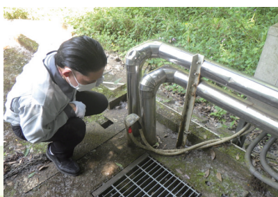
排水状況の確認
