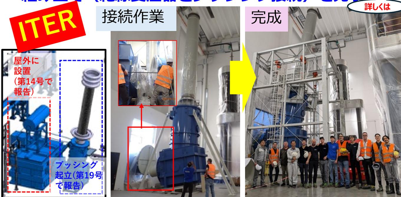
第19号で紹介したブッシングを完成させて、変圧器本体と接続完了
