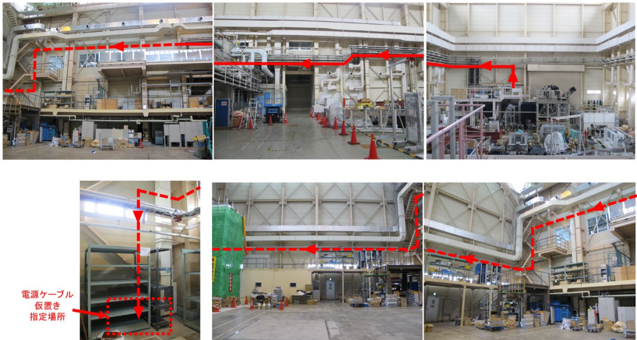
図 4：大実験室内電源ケーブル敷設ルート参考図
