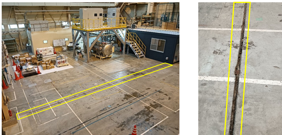
図4 ひび割れ誘導溝補修範囲と拡大図
