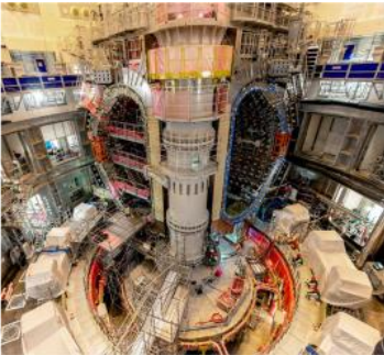
3つ目のセクターモジュール 設置完了 (2025年11月25日)
