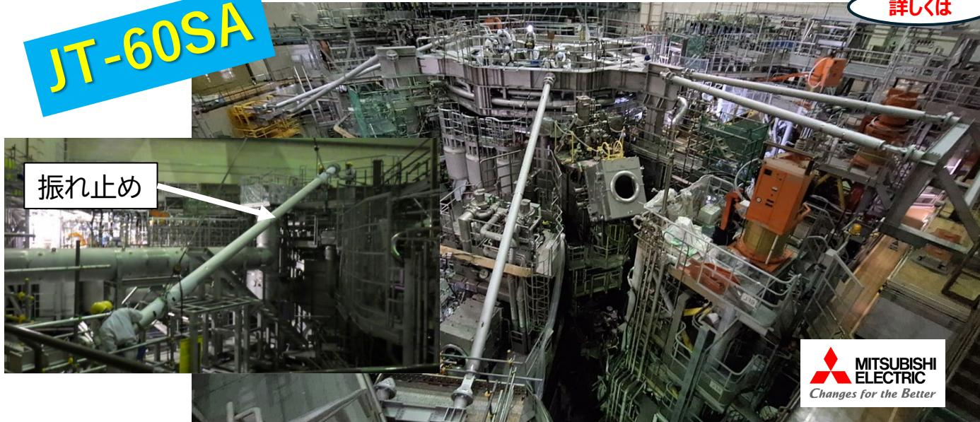
昨年12月にJT-60SAの頂上についた、計測器などを載せる上部架台に運転中に発生する電磁力や地震に耐える振れ止め支持体を設置。
