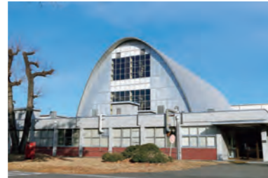
コバルト60ガンマ線照射施設 (供用中)
