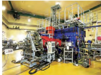
イオン照射研究施設 TIARA (供用中)
