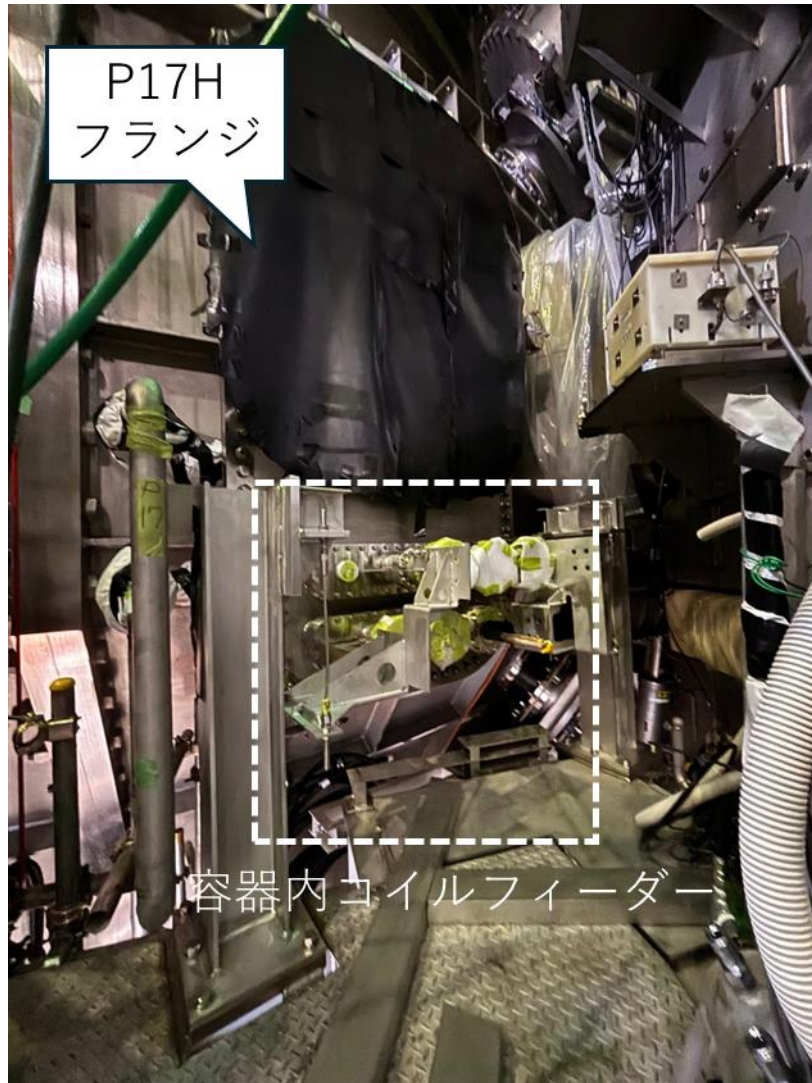
図 3-5 第一フランジの周辺写真(P17H)
