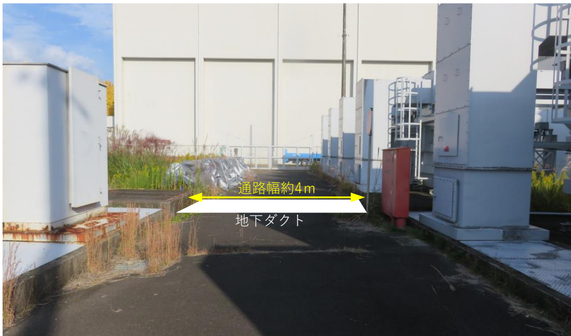
第 7 図 作業実施場所の状況 (2 / 2)
