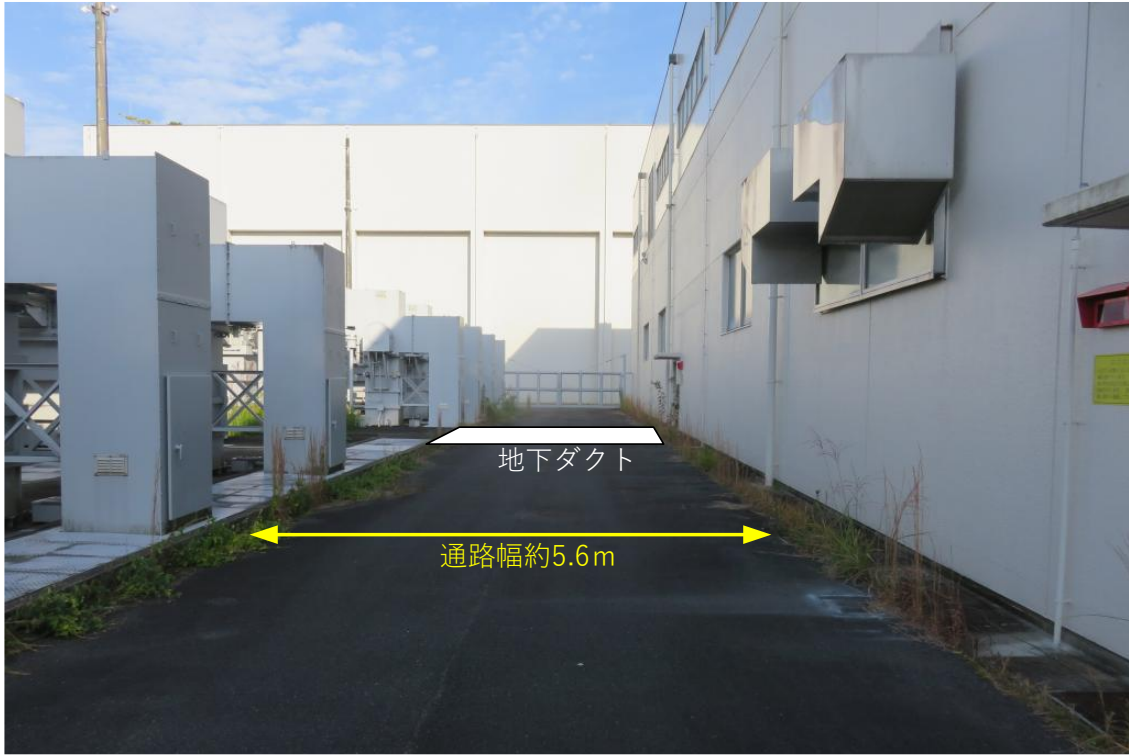
第 6 図 作業実施場所の状況 (1 / 2)
