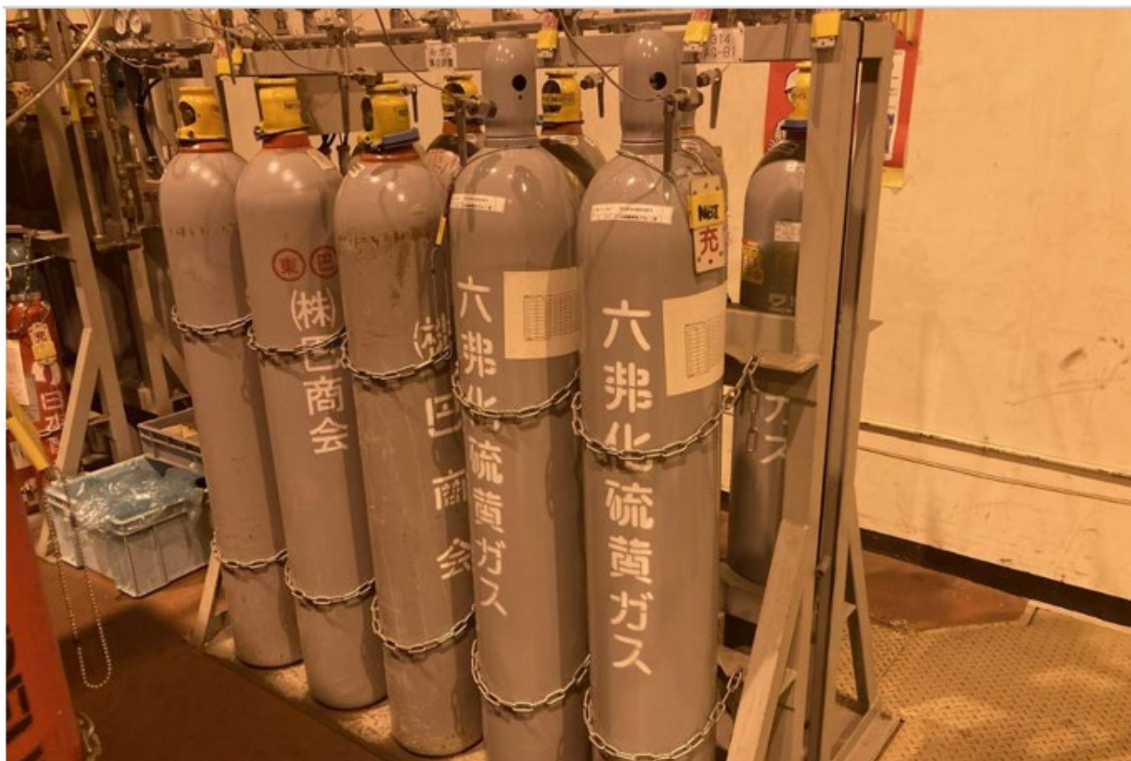
図 5 ヘリウム液化機室 I の SF6 ガス 外観図
