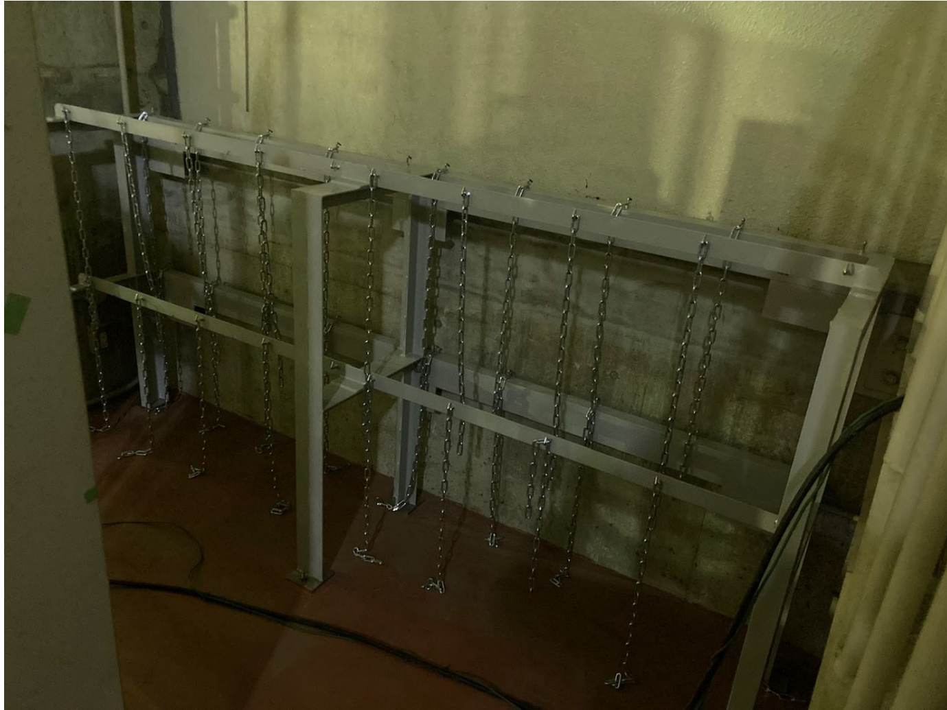
図 6 N-NBI 電源室ポンベ架台 外観図
