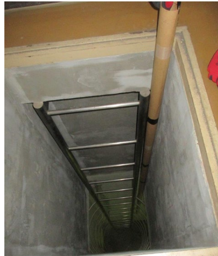
図 7. (a) 図 4 のキャットウォーク貫通部分に設置されている点検口の蓋。赤線は伝送管の敷設想定位置を示している。(b) 点検口に敷設された縦梯子と伝送管の位置関係。褐色の筒はΦ50 の伝送管を模擬した筒である。
