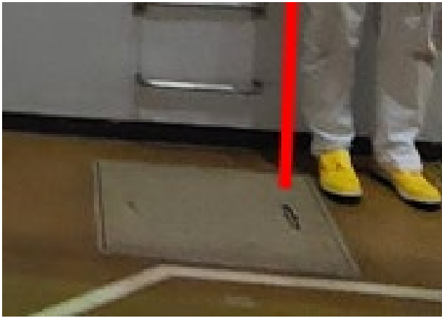
図 7. (a) 図 4 のキャットウォーク貫通部分に設置されている点検口の蓋。赤線は伝送管の敷設想定位置を示している。(b) 点検口に敷設された縦梯子と伝送管の位置関係。褐色の筒はΦ50 の伝送管を模擬した筒である。
