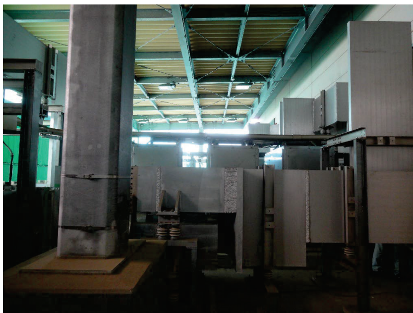
図4 誘引ファン設置場所の現状写真
