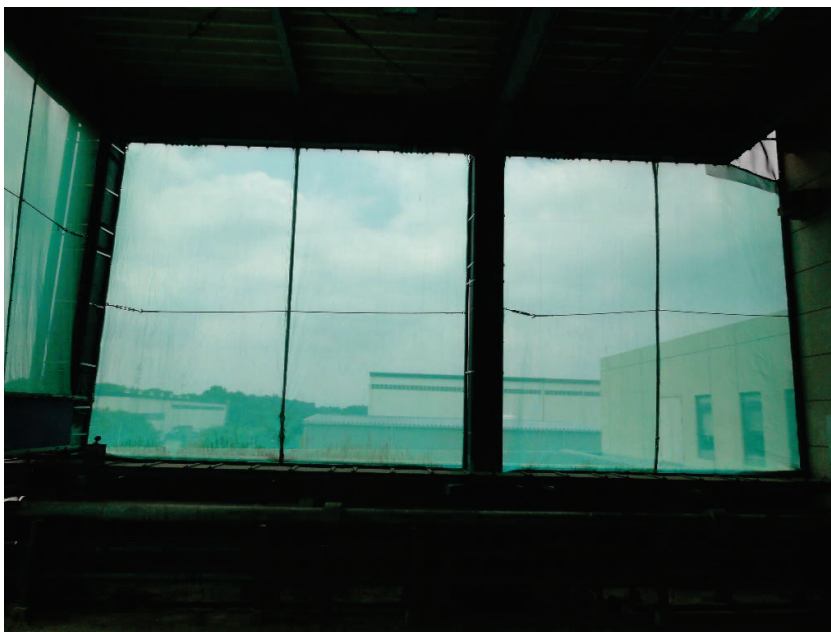
図 5 圧力扇設置場所の現状写真
