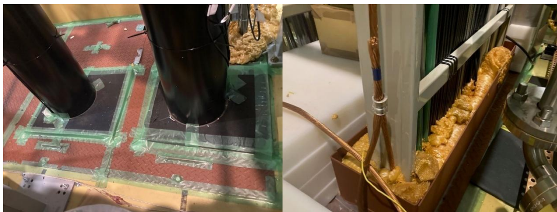
図7 地下ピット貫通物の気密処理状況
