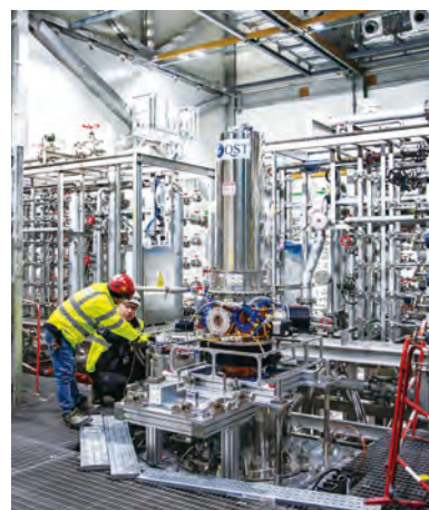
QST/JADAが調達したジャイロトロン 高周波加熱装置の据付時の様子 (©ITER Organization)
