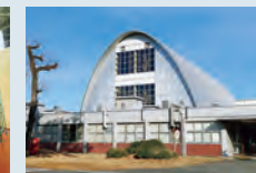
コバルト60ガンマ線照射施設 (供用中)
