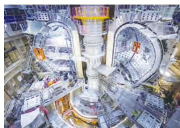
計5基のセクターモジュールが 設置されたトカマクピット内の様子 (©ITER Organization)
