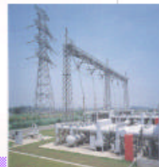
中央変電所 275kV系統の受電設備
