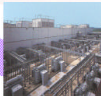
トランスヤード 最大130万kWの電力を扱う 電源設備
