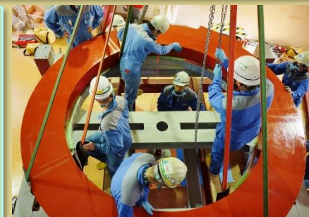
メインコイル交換の様子
