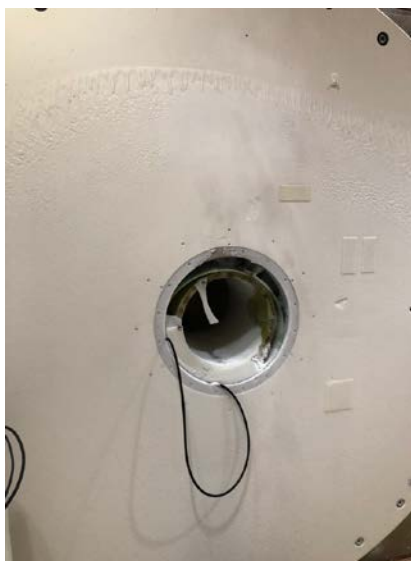
破損したMRI装置 (マグネット前面)
