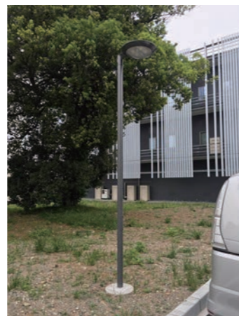
照明器具を環境配慮型に更新
