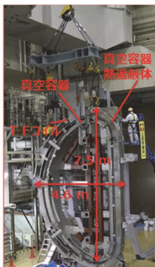
図1. 一体据付した最終セクター
