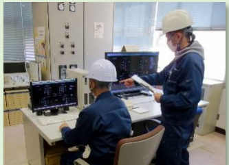
66kV変電所運転管理の様子
