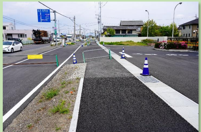
正門前の県道13号線（拡幅工事中）
