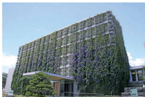
新治療研究棟 外観
