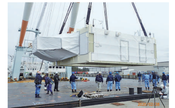
完成した TF コイル一号機を 南フランスの ITER サイトに向け搬出
