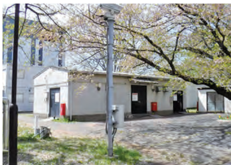
PCB 廃棄物の保管建屋
