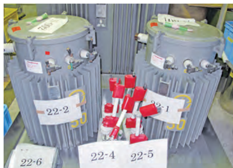
PCB 廃棄物の保管・管理状況
