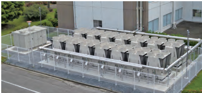
高効率設備機器への更新
