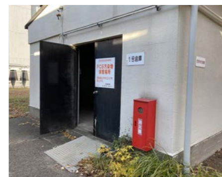
PCB廃棄物保管建屋
