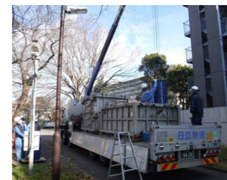
PCB廃棄物搬出作業
