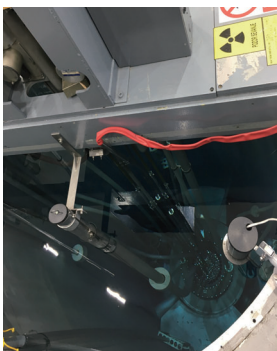
原子炉プールの様子
