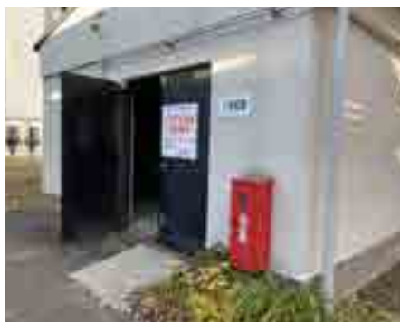
PCB廃棄物保管建屋
