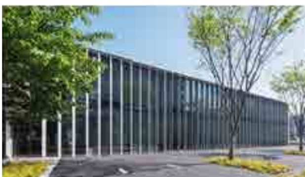
東関東支店（外観）
