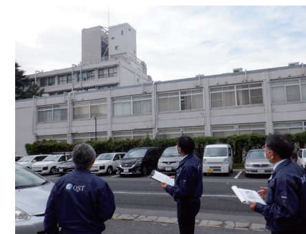
千葉地区第1研究棟
