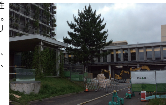
量子メス棟(仮)着工の様子
