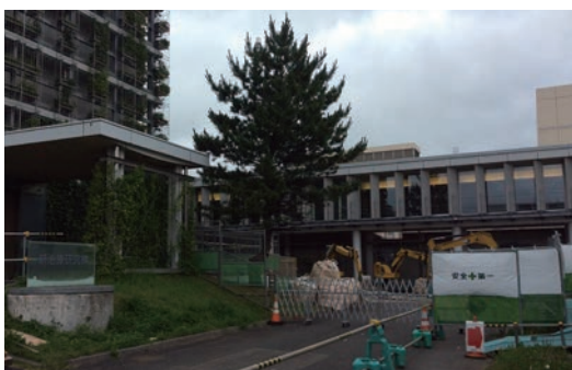
量子メス棟(仮)着工の様子
