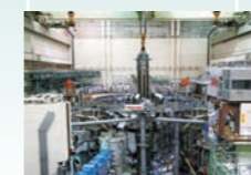
⑥ 中心ソレノイドを装置中心部に設置(2019年5月)
