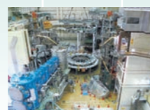
③ 那珂研で製作を進めてきた大型のEF5設置の様子(2014年1月)
