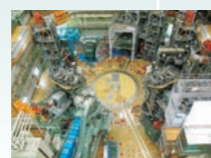
② 超伝導トカマクJT-60SAの組立を開始(2013年1月28日)
