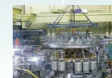
⑦ クライオスタット上蓋部設置(2020年3月)
