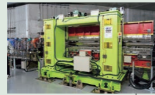
蓄積リングトンネル内の挿入光源
