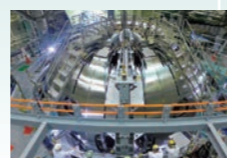
④ 組立中の真空容器及びサーマルシールド(2016年9月)
