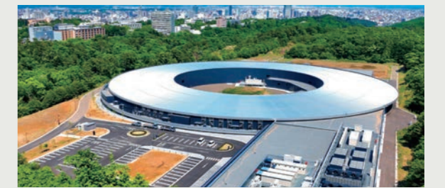
3GeV高輝度放射光施設 NanoTerasu (共用促進法による共用)
